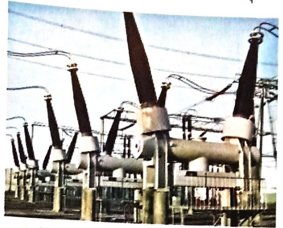
รูปที่ 8.17 ก๊าซ SF6 เซอร์กิตเบรกเกอร์
