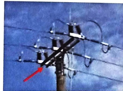
รูปที่ 8.18 การติดตั้งดิสคอนเน็กต์สวิทช์และการติดตั้ง
