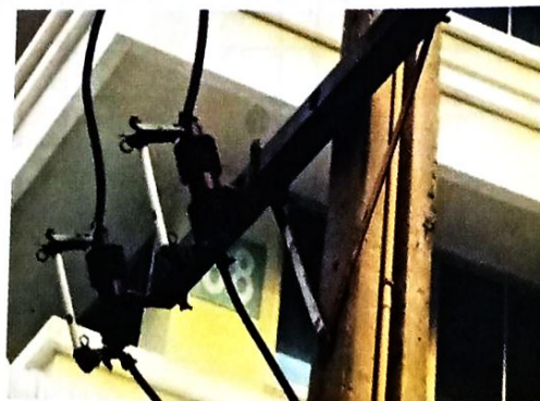
รูปที่ 8.8 ฟิวส์ตัดตอนแรงสูงและการใช้งาน
